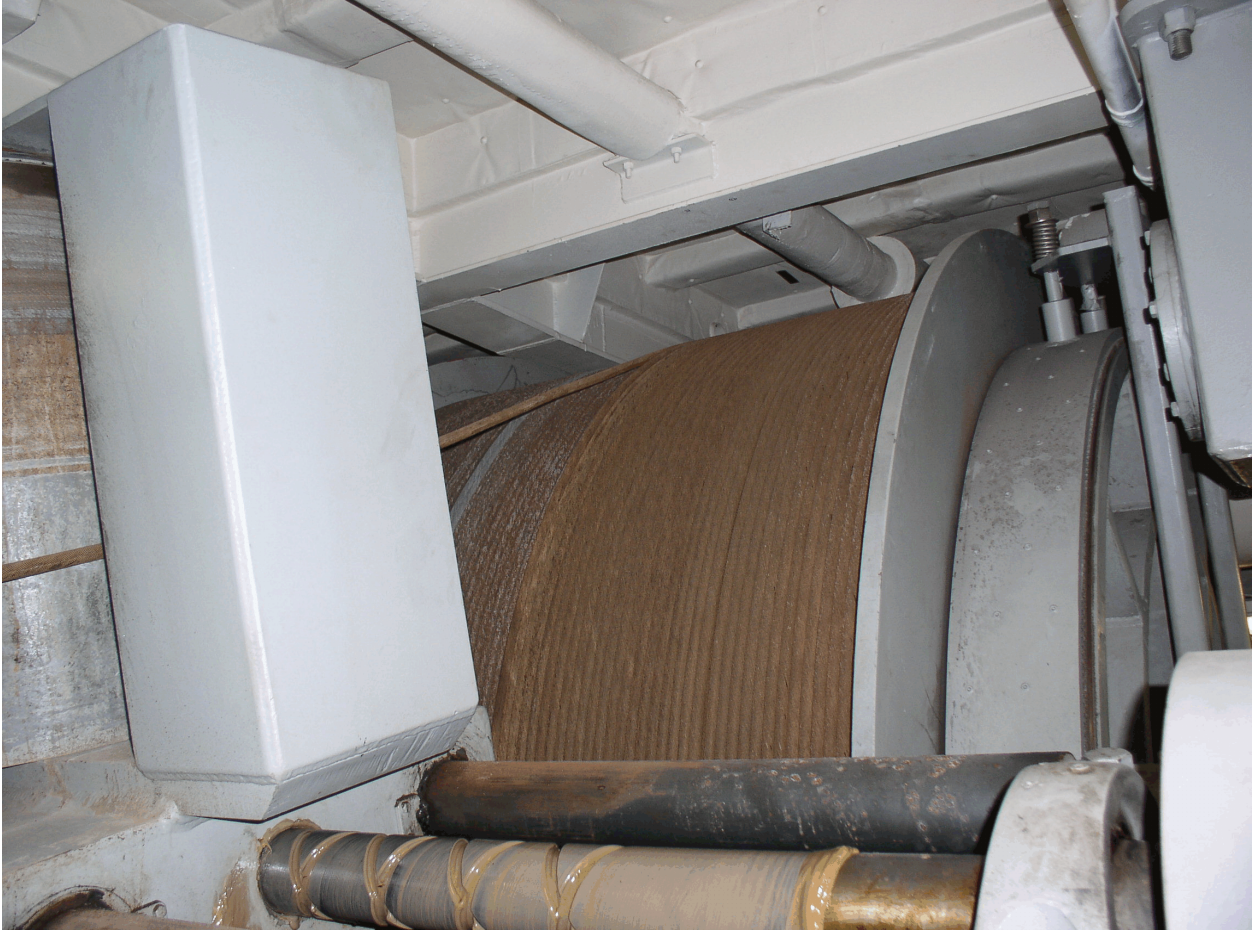
Heavy rust on 0.680 EM Cable
